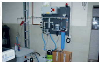
Das Reinwassersystem ermöglicht Druck ohne chemische Zusätze.
