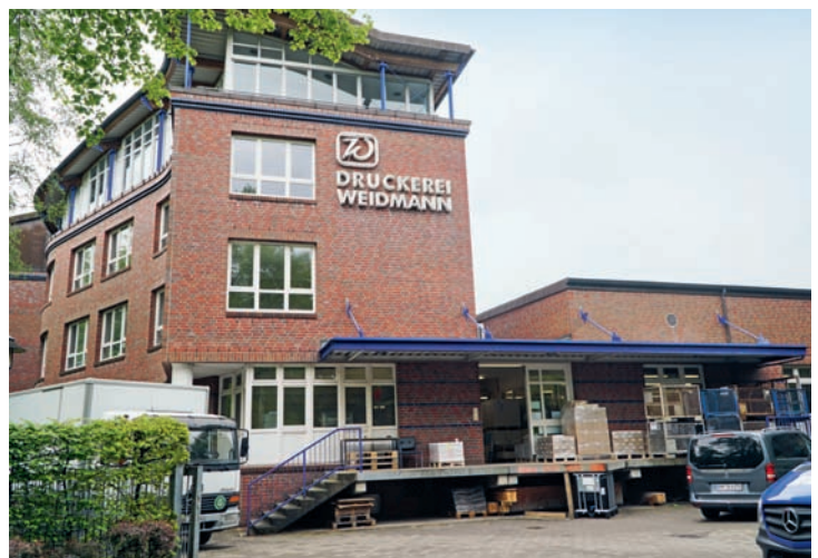
Ihren aktuellen Standort in Hamburg bezog die Druckerei Weidmann in den frühen 1960er-Jahren. Er wurde schrittweise erweitert.
