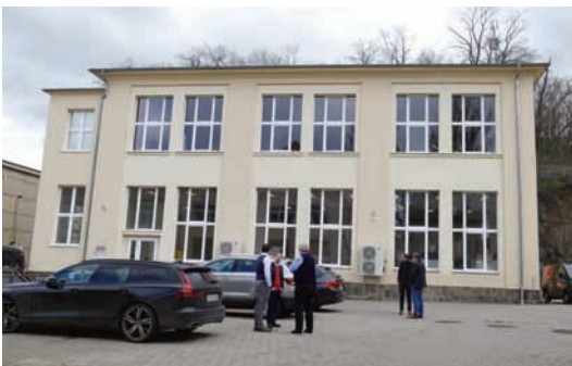
Im Rohbau-Zustand übernommen, alsbald saniert und im November 2017 bezogen: Der neue Standort der Digitaldruckerei Schleppers GmbH in der Spreegasse in Bautzen.
